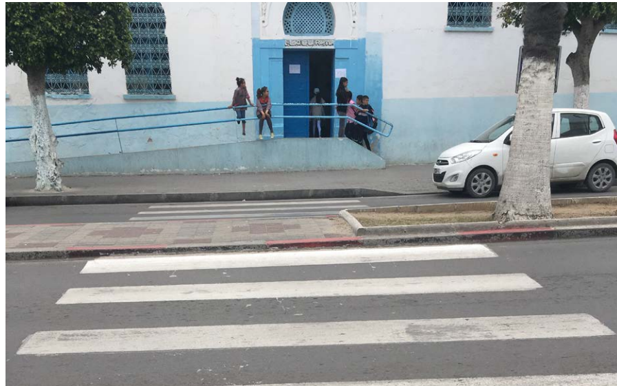
Figure 29 : Manque d'accessibilité PMR au niveau d'une traversée piétonne d'une école, source : Transitec
