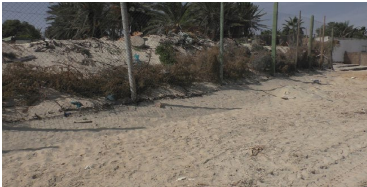
Photo.4 Les hôteliers se défendent comme ils peuvent, ils élèvent des digues de sables, les tassent, les consolident par des gros blocs, élèvent les barbelés pour empêcher les pénétrations et les passages des intrus.
