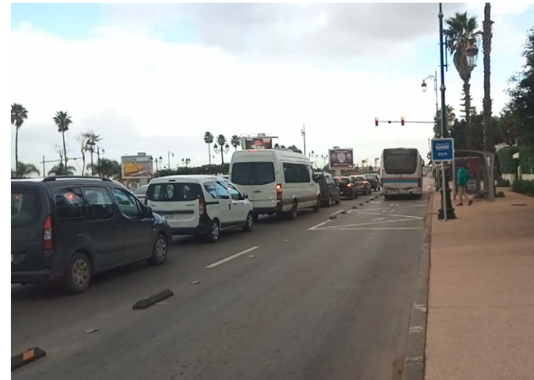
Exemple de voie bus à Rabat (Maroc), Avenue Abderrahim Bouabid – Source Transitec
