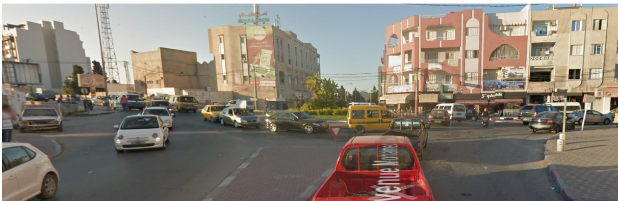
Carrefour giratoire P1-Av. M. Karoui, un aménagement représentatif des giratoires à Sousse : absence de traversées piétonnes, flux motorisés important, stationnement des véhicules dans l'anneau créant des masques
